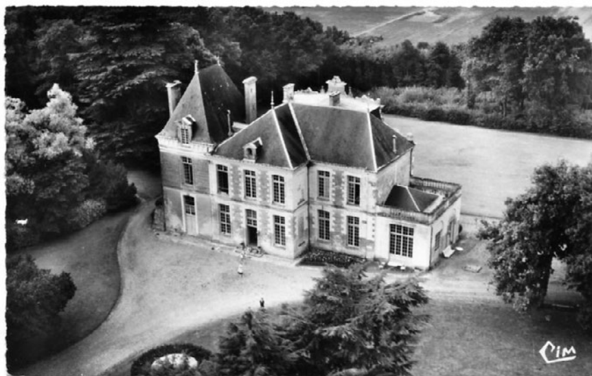
La Ribochère, façade sud (on devine l'ancien fronton de la façade nord) 1680
